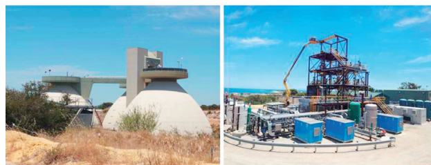
図7 Hazerでの見学の様子 (左図) 汚泥由来のメタン回収装置 (右図) Hazerプロセス実証プラント
